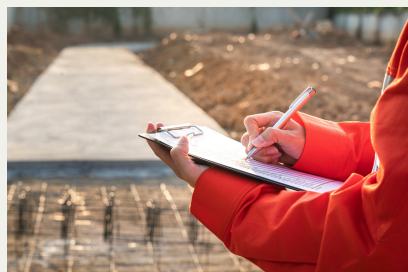
敷地調査/土地探し
