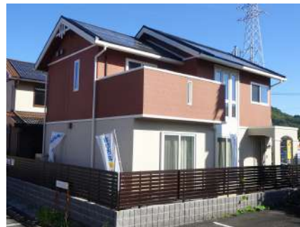
3号地外観: 2023年9月撮影
